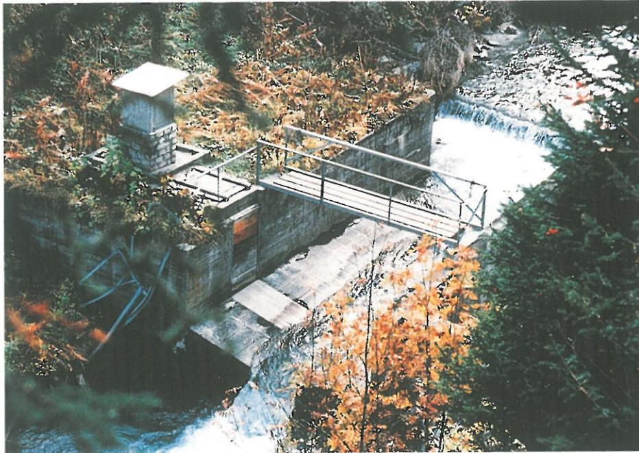
Fig. 4 Station mit Gemischstandmessung. Beispiel Dischmabach bei Davos, Graubünden.
